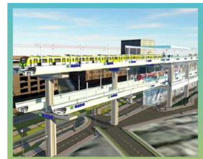
ಸಿಂಗಲ್ ಪಿಯರ್ / ಪೋರ್ಟಲ್ ರಚನೆಯಲ್ಲಿ ರೈಲ್ ಓವರ್ ರೈಲ್: ಯಲಹಂಕದಲ್ಲಿ ಕಾರಿಡಾರ್ 1 ಮತ್ತು 4ರಲ್ಲಿ BSRPಯ ಸಮಗ್ರ ಜೋಡಣೆ
