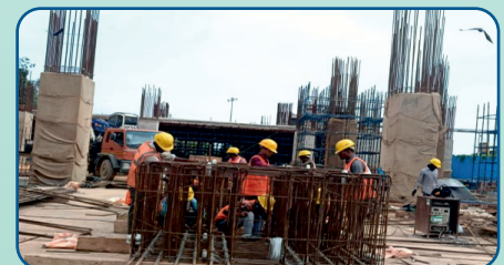
C-76 Barrette panel cage fabrication
