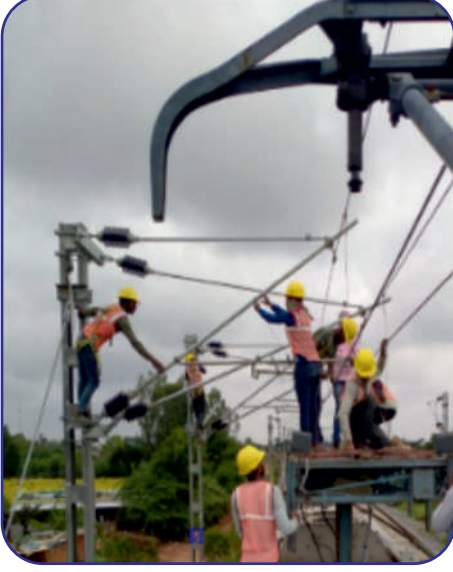
ಟವರ್ ಕಾರ್ ಪರಿಶೀಲನೆ ಮತ್ತು IOL (Insulated Overlap) ನಿರ್ಮಾಣ: ದ್ವಿಪಥೀಕರಣ ಕಾಮಗಾರಿಗಳ ಭಾಗವಾಗಿ, ಮಾರನಾಯಕನಹಳ್ಳಿ ಯಾರ್ಡ್‌ನಲ್ಲಿ IOL ನಿರ್ಮಾಣ ಕಾಮಗಾರಿ ಪೂರ್ಣಗೊಂಡಿದೆ.
